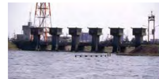
江戸川水閘門
