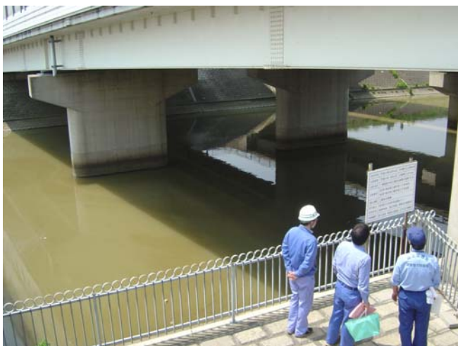
三郷放水路を横断している外環自動車道の検査状況
