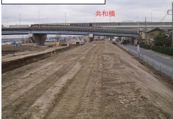
H19 木曽根上流築堤工事
