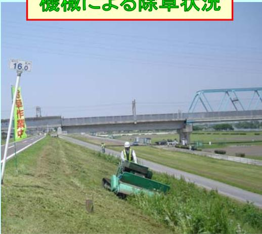
江戸川河口出張所では、堤防の除草を年3～4回実施しています。堤防の除草は、堤防が壊れていないかの確認や、増水時に民地（市街地）側に川の水が噴き出した時に確認しやすくすると共に対策工法をしやすくするためのものです。
