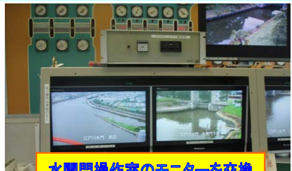
水閘門操作室のモニターを交換
