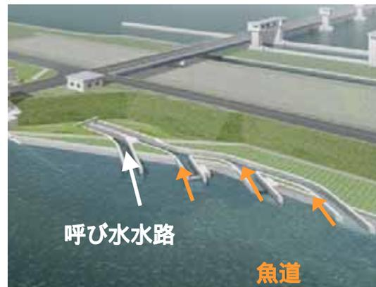
魚道の敷高は水位変動に対応できるように3段階とし、稼働率をあげている。
