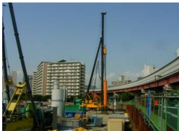
施工状況(深層混合処理)
