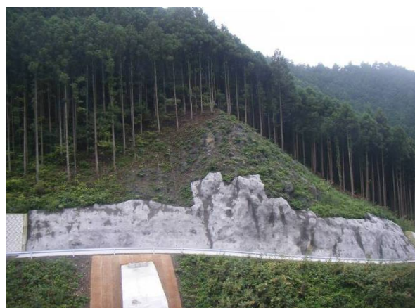
付け替え道路の法面对策工
