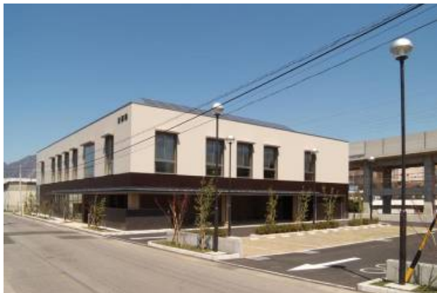
完成又は施工状況写真
