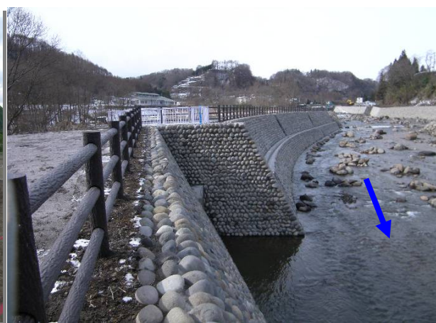
完成(下流右岸より上流を望む)
