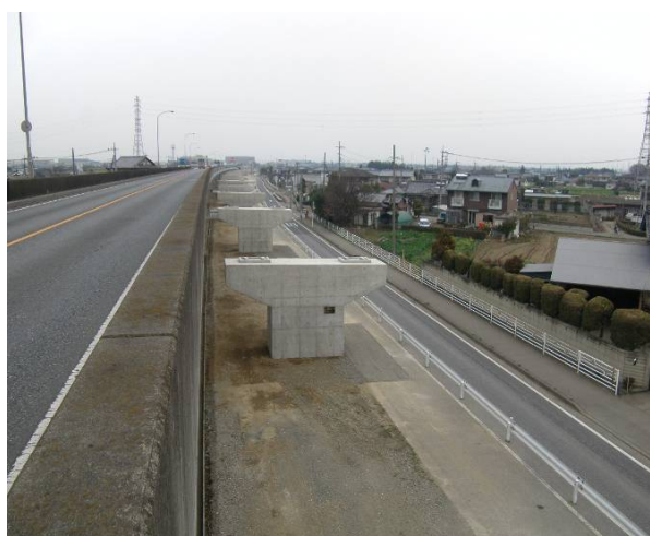
供用中の下り線高架橋上より全景を望む
