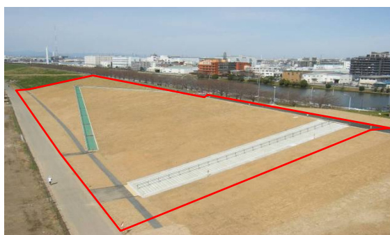
写真-1 完成写真
