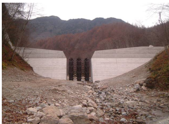
タケノ沢第2砂防堰堤
