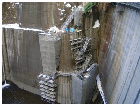
管理用通路施工状況
