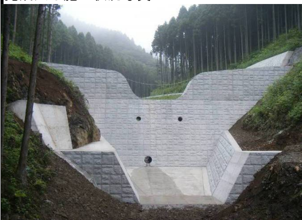
完成した堂場沢砂防堰堤
