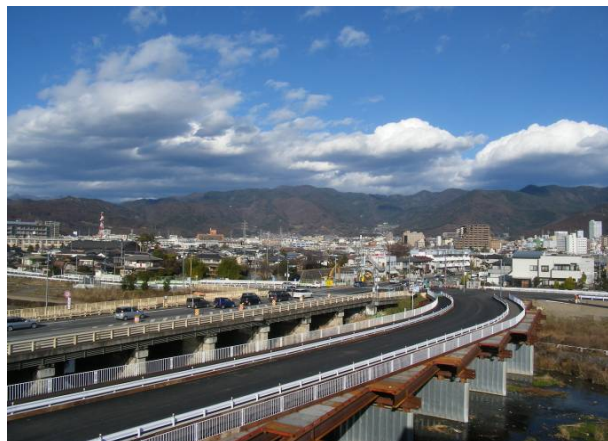
完成又は施工状況写真
