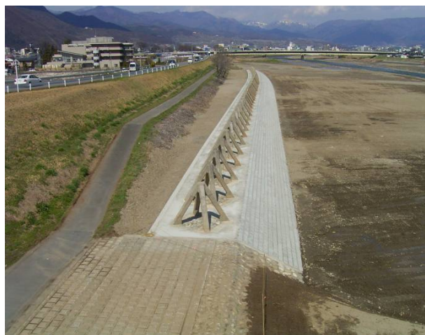
完成又は施工状況写真
