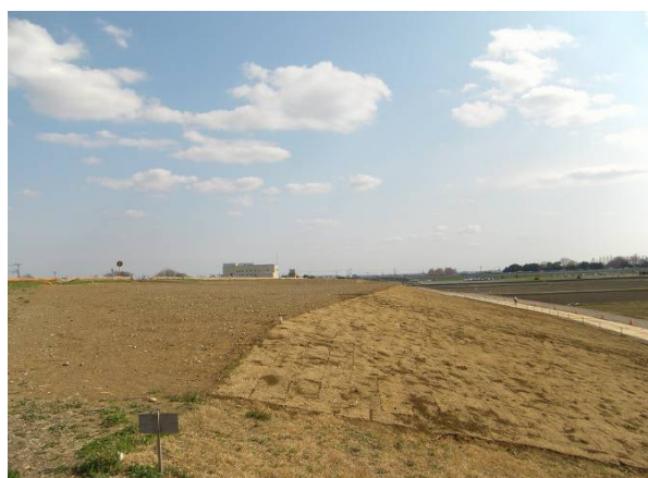
完成(上流より下流を望む)
