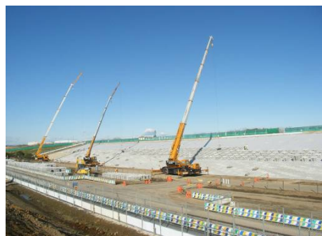
写真-2 施工状況
