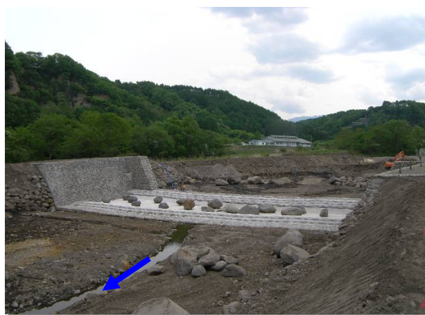
完成(下流左岸より上流を望む)
