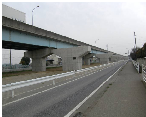
新橋橋脚、旧橋RC巻立てを施工
