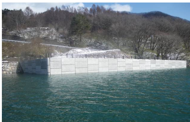
作業構台竣工状況
