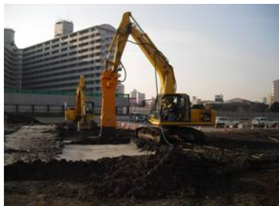
施工状況(浅層改良工)
