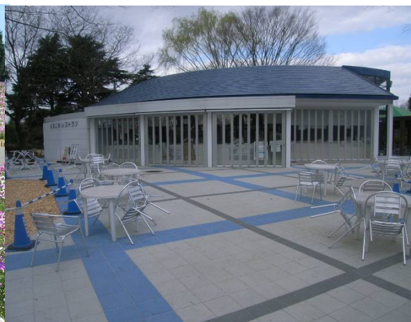
平板舗装(溪流広場)
