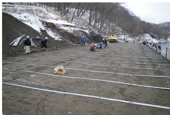
作業構台施工状況
