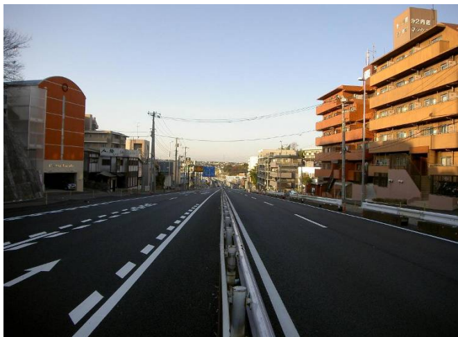
完成又は施工状況写真
