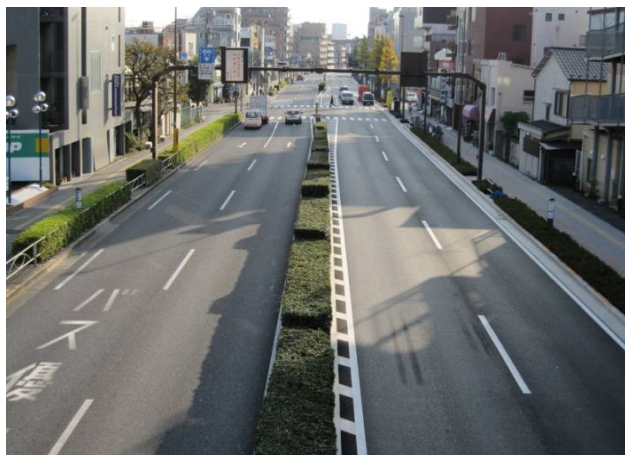
工事終点から工事起点を望む
