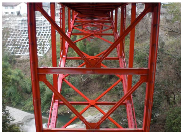
完成又は施工状況写真
