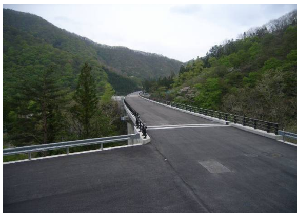
完成又は施工状況写真
