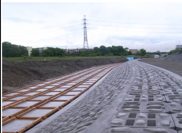
完成又は施工状況写真
