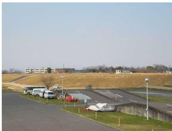
完成(下流より上流を望む)
