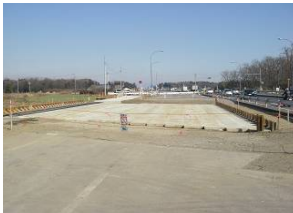
完成又は施工状況写真
