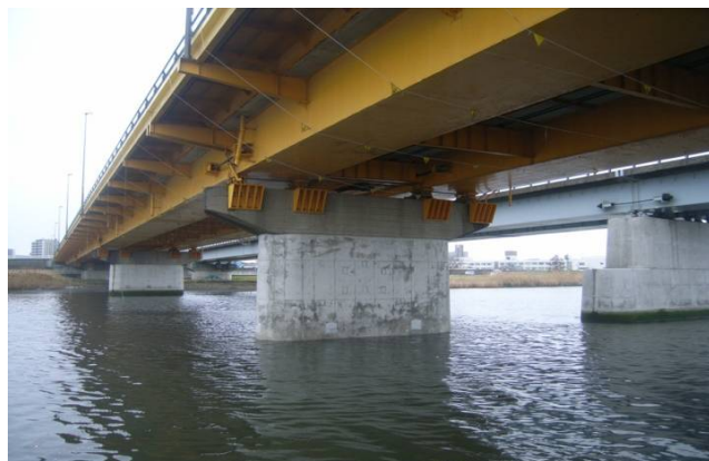
完成又は施工状況写真 完成
