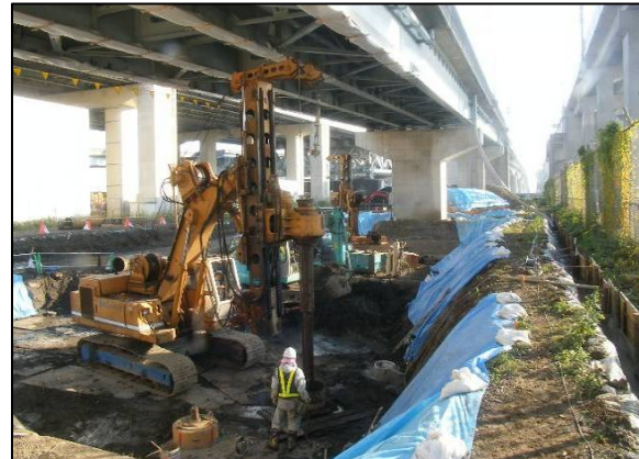
地中障害物撤去
