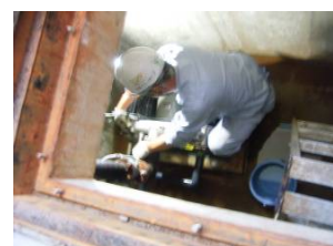
中之島公園内トイレの点検
