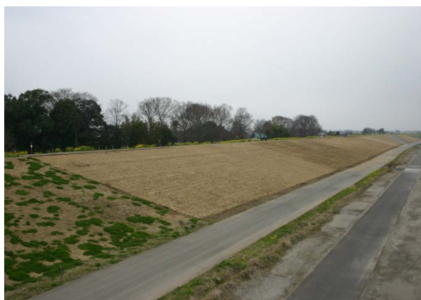
完成又は施工状況写真
