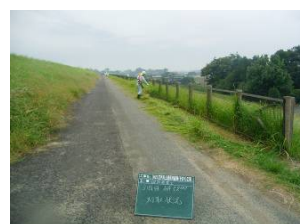
支障物周辺の先行除草
