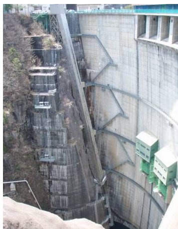
管理用通路竣工状況
