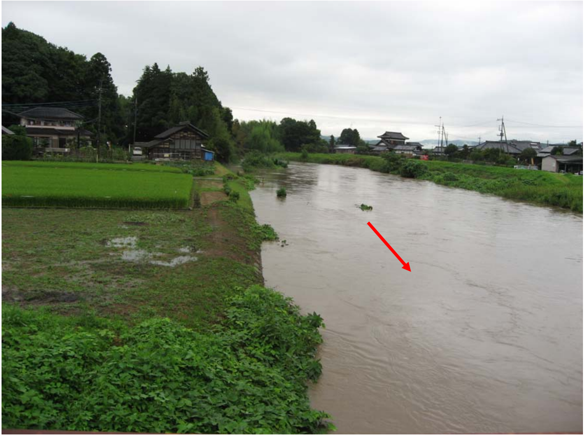
出水状況写真（台風9号） 久慈川水系浅川（常陸太田市）
