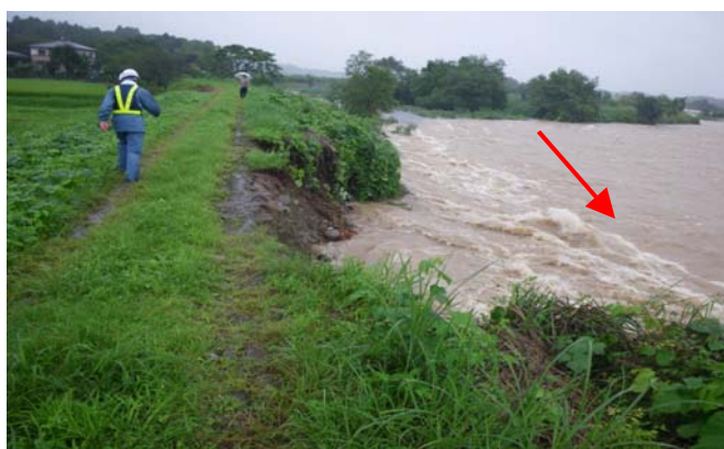
一級河川箒川 那須塩原市宇都野地先 出水・被災状況
