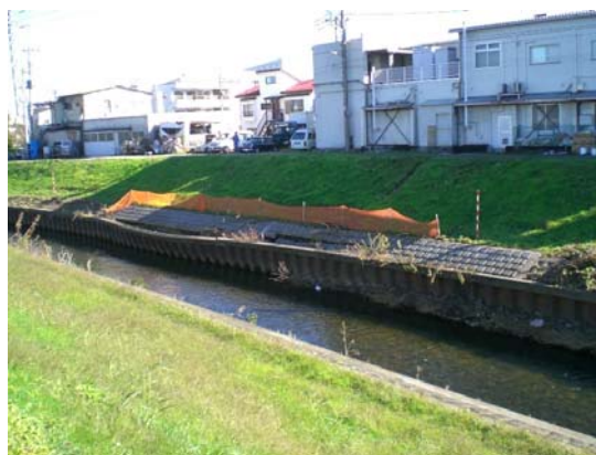
河川施設被災状況（朝霞市：黒目川）
