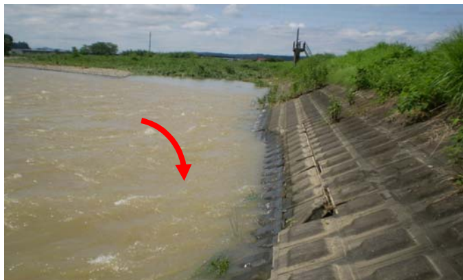
一級河川荒川さくら市松島地先 出水・被災状況
