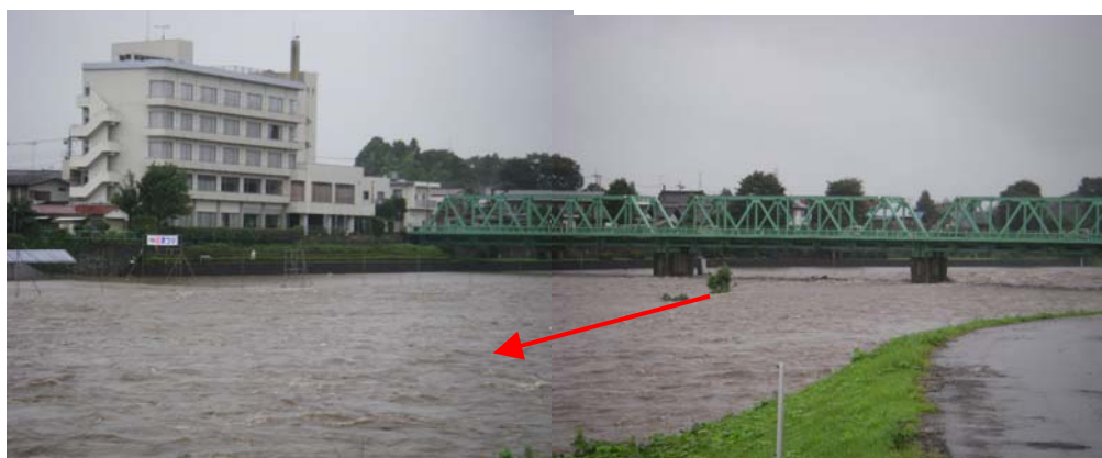
一級河川那珂川 大田原黒羽向町那珂橋下 出水状況
