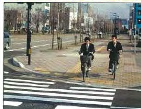
自歩道幅員の確保及び段差の解消
