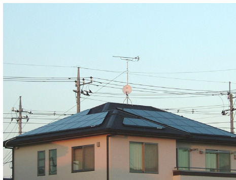
ソーラーパネルを設置している住宅
