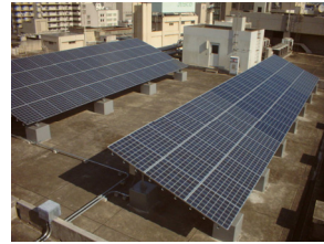
太陽光発電の例 (千葉第2地方合同庁舎)
