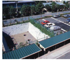
住宅地の一角に設けられた調節池・浸透井
