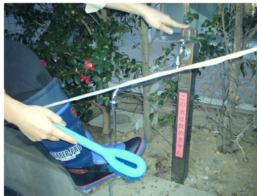
雨水を洗浄水として使用
