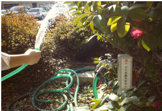
雨水を植栽への散水として使用
