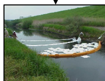
(オイルフェンスと吸収マットによる油の流出対策例)
