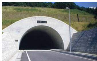
安榛トンネル
