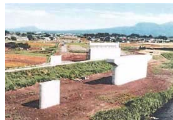
荒砥橋梁下部工事完成
