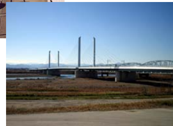
完成した新橋
