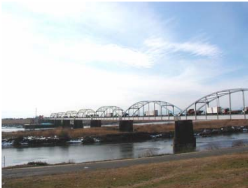
工事前の昭和橋
