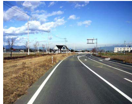
部分供用箇所
