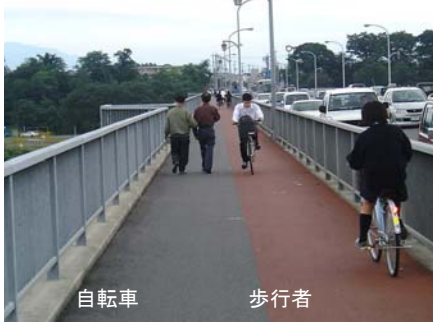
歩道が色分けされた（主）前橋箕郷線 ※自転車の通行区間を茶色で表示
