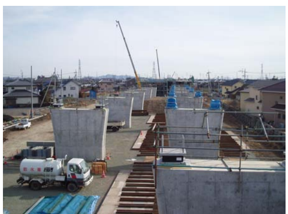
【工事中の東高架橋】
