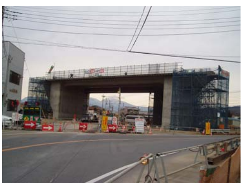
【工事中の藪塚橋】
