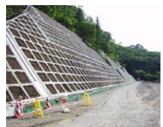
【整備前の現道】
