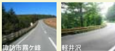
図: 信州型木製ガードレール【長野県】
