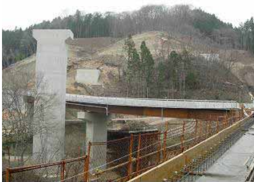
【上信自動車道(国道145号)】
