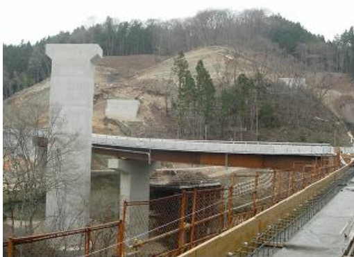
【上信自動車道(国道145号)】
