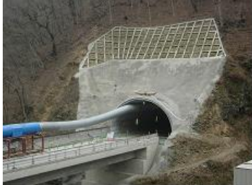
【上信自動車道(国道145号)】
