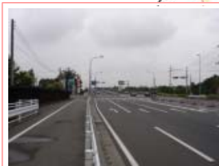
国道50号 岩舟小山バイパス
