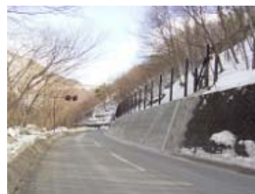
ブロック積擁壁・落石防護柵
