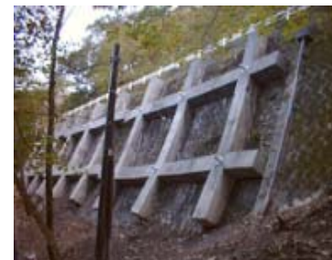
法枠・グラウンドアンカー
