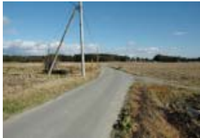
狭く屈曲した道路線形
