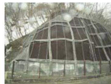
法枠・落石防止網・グラウンドアンカー
