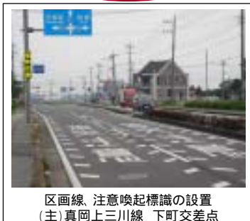
緊急対策の例 (事故危険箇所)
