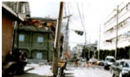
阪神大震災で倒壊した電柱
