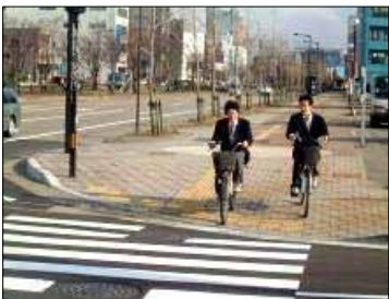
自歩道幅員の確保及び段差の解消
