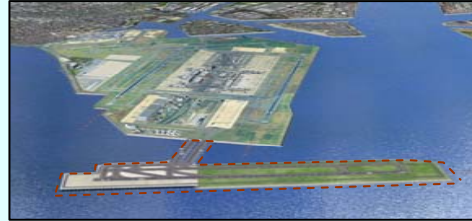
東京国際空港(羽田)再拡張事業
