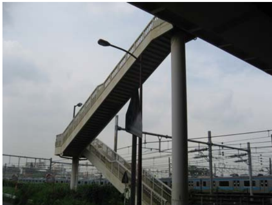
<東北線跨線橋上り階段>
