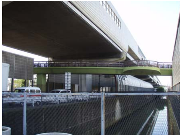
<岸川中学校前歩道橋>
