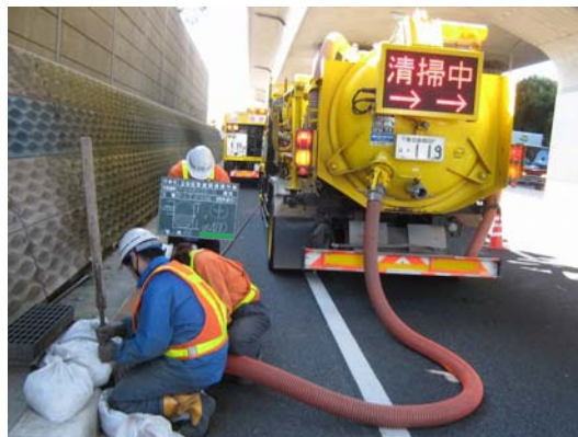
<排水構造物清掃>
