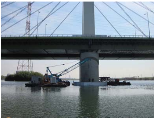
< 橋脚補強工事 (河川内) >
