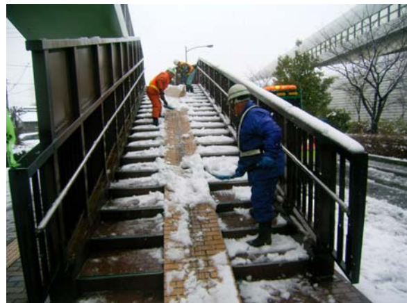
<歩道橋人力除雪>
