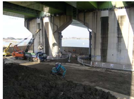
< 橋脚補強工事 (陸上部) >
