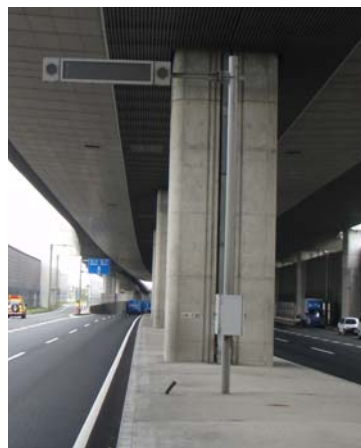
< 冠水警報の電光表示板 >
