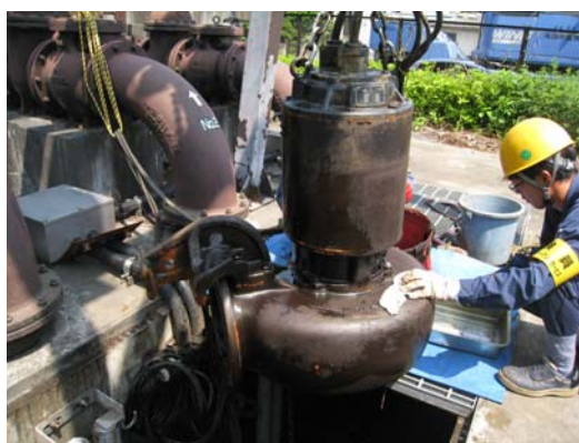
<排水設備（点検状況）>
