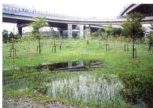
写真 川口 JCT のビオトープ整備状況
