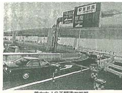
美女木JCT開通で首都圏と東京外環が接続 美女木JCT開通で首都圏と東京外環が接続
