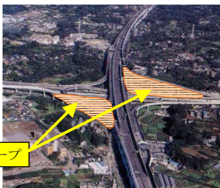
写真 川口 JCT (空撮)
