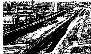
供用開始の国道296号外回り線
