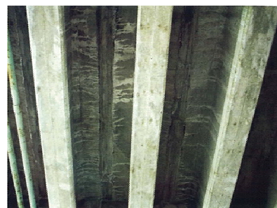
床版の遊離石灰漏出状況
