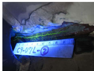
鋼床版の亀裂の状況
