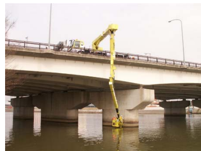
橋梁点検状況（橋梁点検車）
