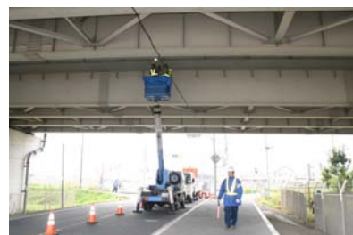
橋梁点検状況（リフト車）
