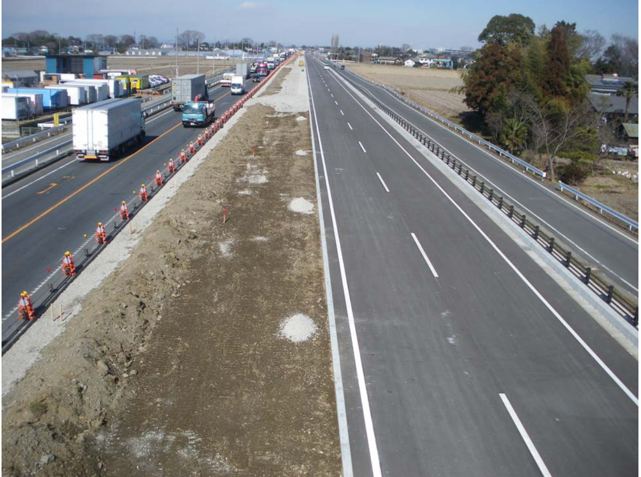
宇都宮方向を望む（対面通行の状況）
