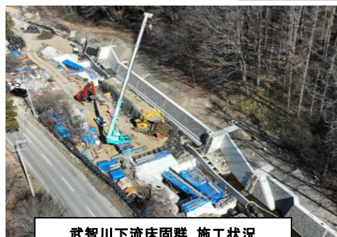
武智川下流床固群 施工状況
