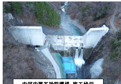
内河内第五砂防堰堤 施工状況
