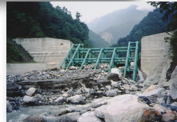
おおたなざわだいにさぼうえんてい 砂防堰堤(透過型): 大棚沢第二砂防堰堤
