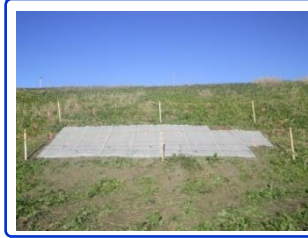
堤防の補修完了
