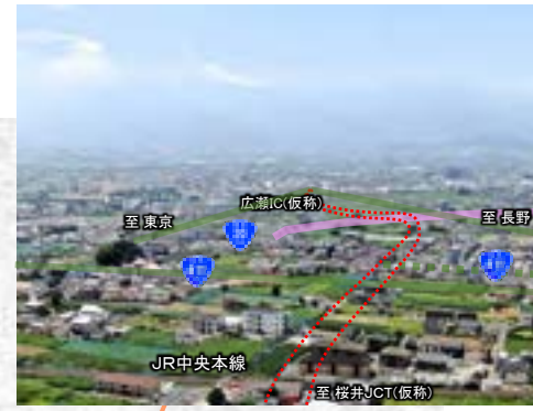
広瀬～桜井の現地状況
