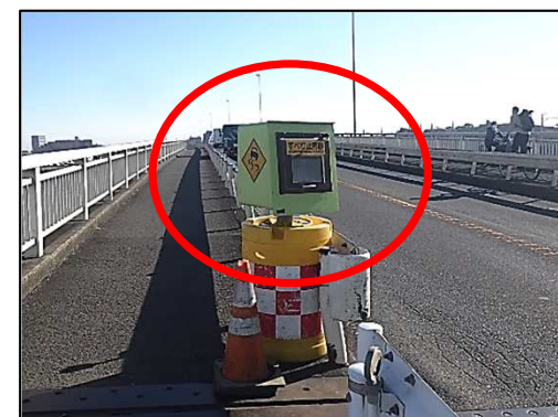
国道1号馬入橋(神奈川県平塚市)
