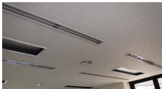
天井 既存空調吹出し口
