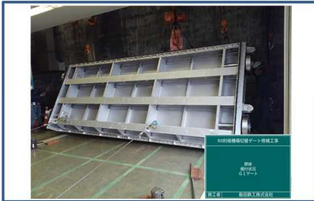
扉体(G1ゲート)施工状況
