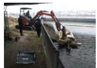
不法係留船撤去工
