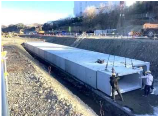
水路工施工状況
