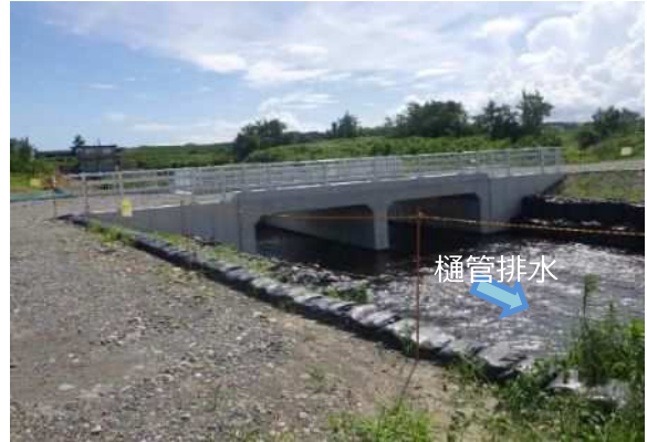
堤外水路工 完成
