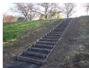
擬木階段設置工
