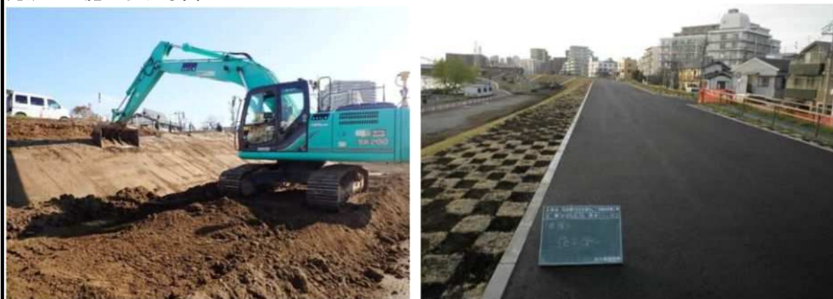
ICT施工による法面整形状況
