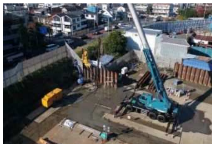
住宅・工場近接施工状況(矢板施工)状況
