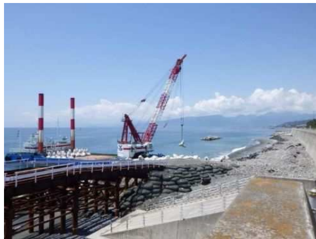
根固めブロック据付け状況
