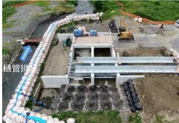
堤外水路工施工状況
