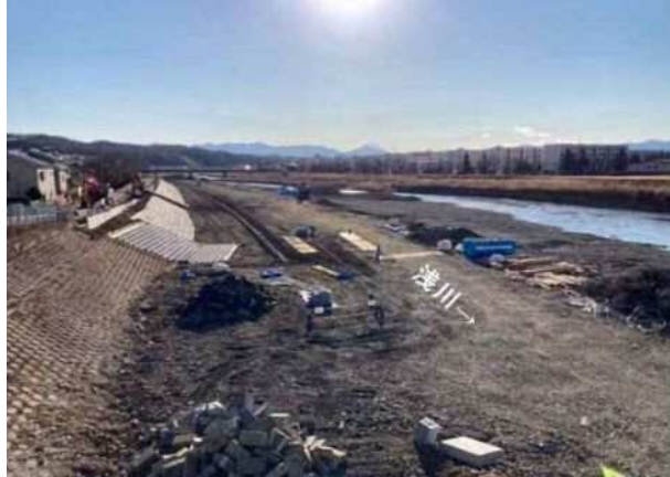
護岸工施工状況
