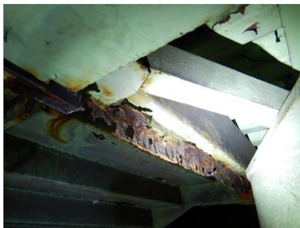
・地覆の腐食 <地覆部分補修>
