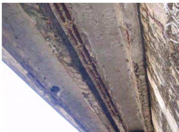
・主桁の腐食 <縦桁部分補修>
