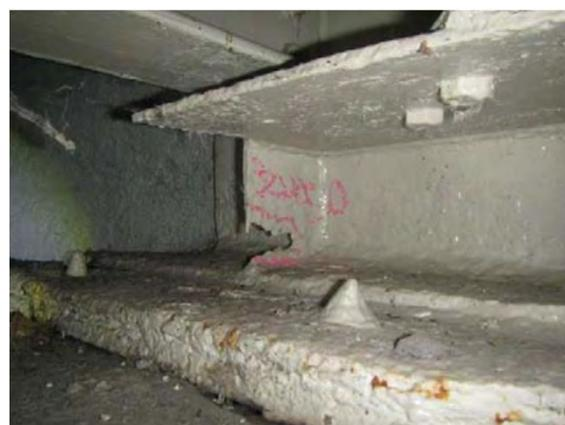
・横桁の腐食 <横桁部分補修>
