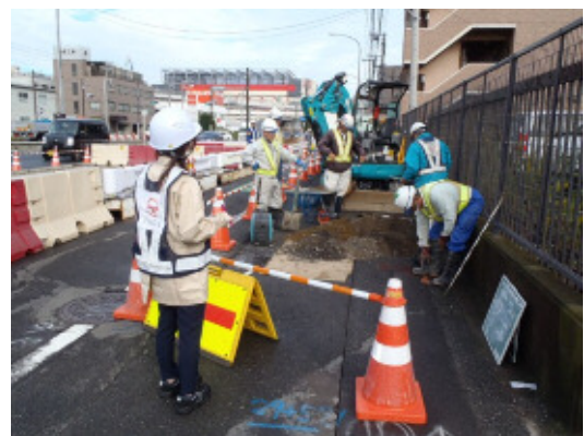
②安全巡視状況
