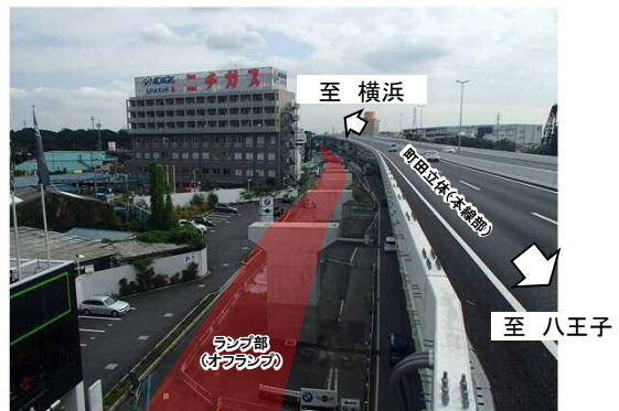
② ランプ部（オフランプの施工状況）
