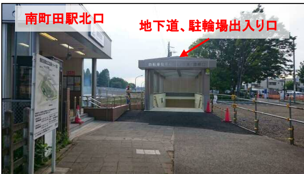
新設されている地下道出入口
