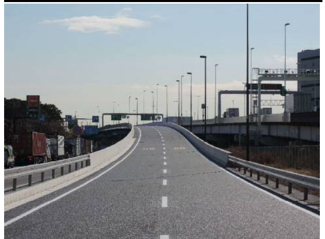
写真② 横浜方面側 立体部より撮影 (横浜方面を望む)
