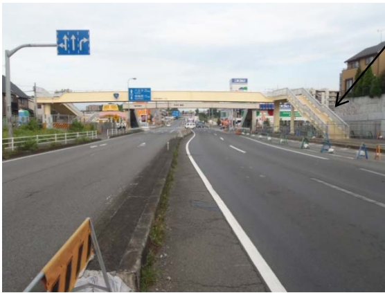
【横浜方面より歩道橋を望む】
