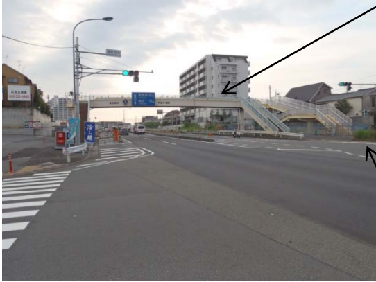
【八王子方面より歩道橋を望む】
