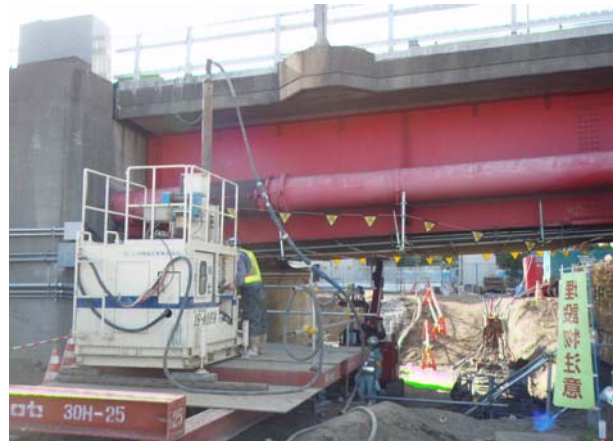
地盤改良工施工状況
