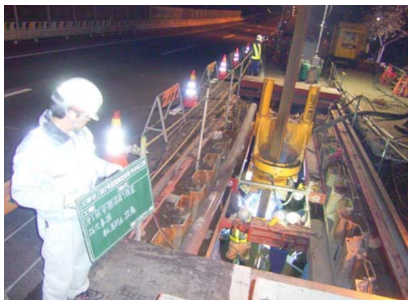
鋼矢板締切工施工状況
