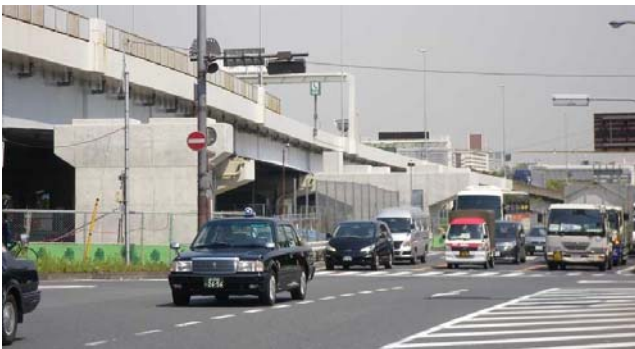
現在の状況(千葉方面を望む)
