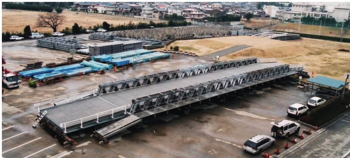
応急組立橋（関東技術事務所 船橋防災センター）
