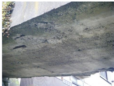
〈橋梁損傷の状況 (コンクリート剥離、鉄筋露出)〉
