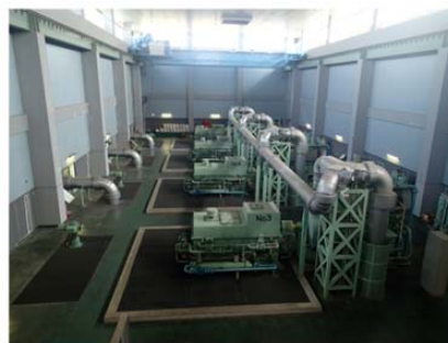
【河川ポンプ設備】
