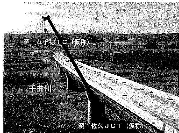
長野県内区間(千曲川橋付近)での工事状況
