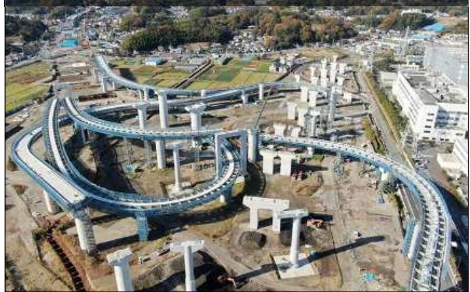
圏央道（神奈川県区間） 横浜環状南線 栄IC・JCT
