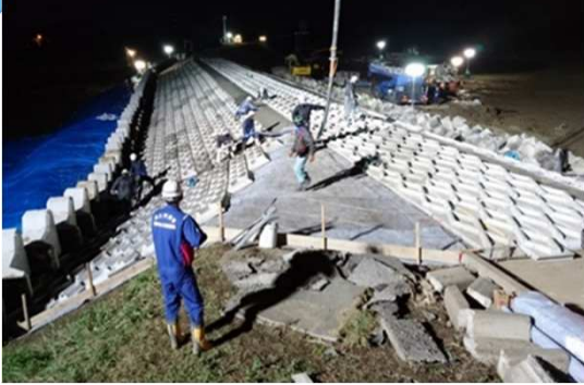
R1台風19号における堤防復旧状況
