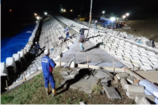
R1台風19号における堤防復旧状況
