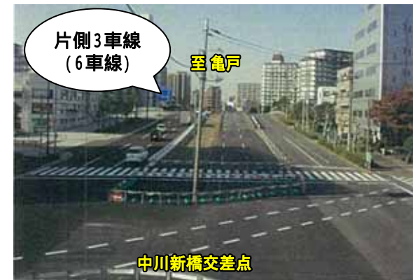
写真 拡幅後の道路状況 H17.11.12撮影
