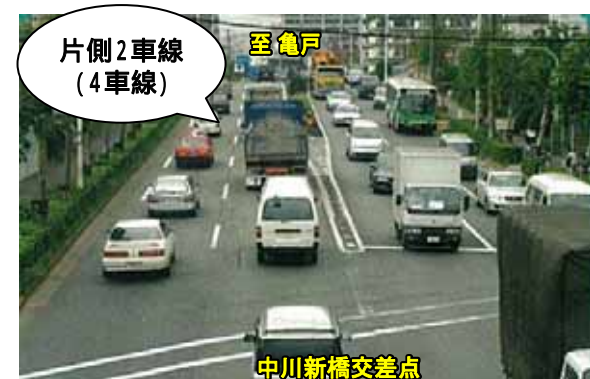
写真 拡幅前の道路状況
