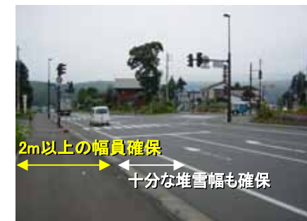
写真 整備済区間における通学路の状況(幅員2m以上)
