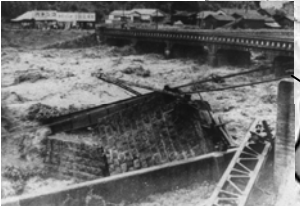
昭和34年災害 (関東地方整備局関東地方水害写真集 昭和57年2月発行より)
