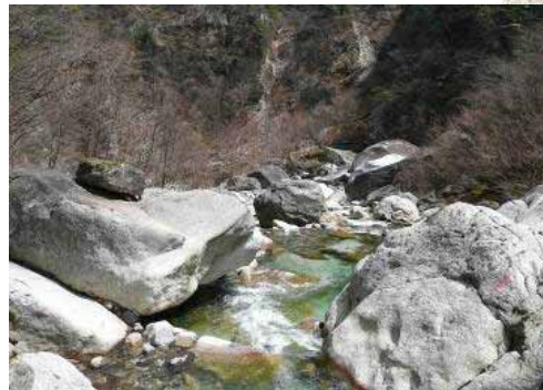
大武川第五号砂防えん堤上流の河床状況
