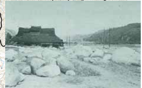
S34災害 牧原地区 土石流流下後に残った大転石群
