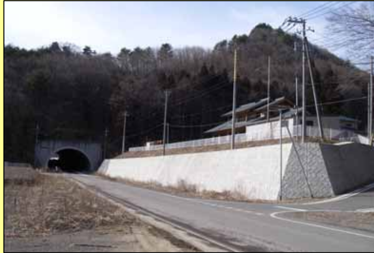
にれぎ 付替県道及び代替地関連工事(楡木地区)
