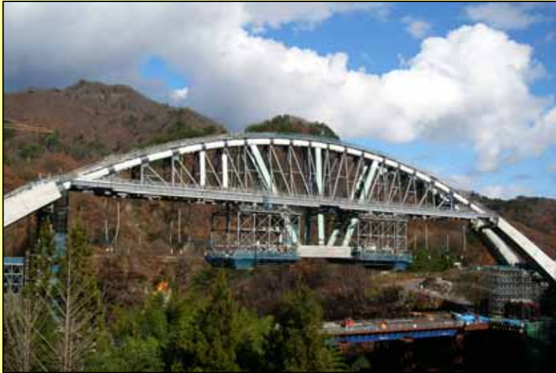
あがつまがわ 付替鉄道工事(第三吾妻川橋梁)
