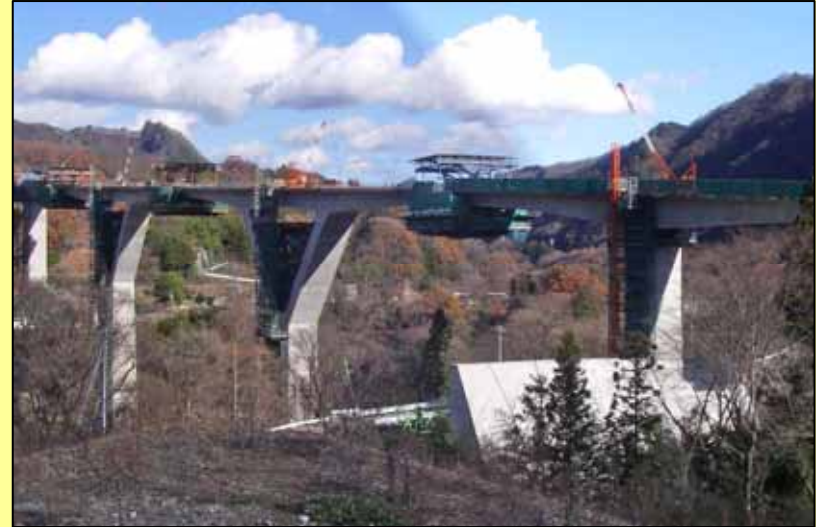
付替国道工事(湖面3号橋)
