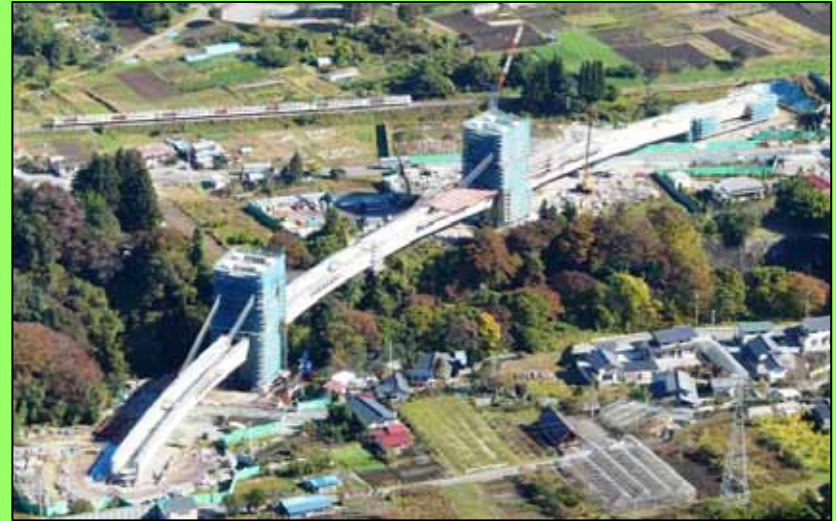
あがつまがわ 付替鉄道工事(第二吾妻川橋梁)
