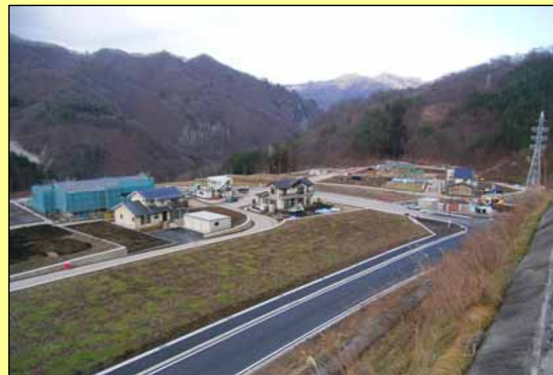
うちこし 付替県道及び代替地関連工事(打越地区)
