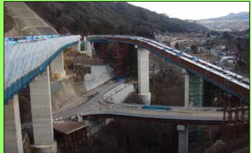
がながさわ 付替国道工事(雁ヶ沢ランプ)
