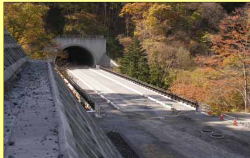
おおさわ 付替県道工事(大沢橋・川原湯温泉トンネル)
