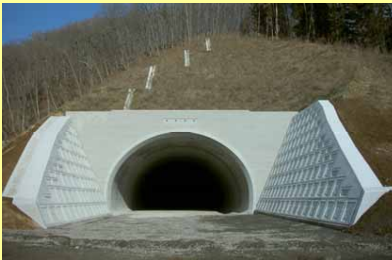
もしろう 付替国道工事(茂四郎トンネル)
